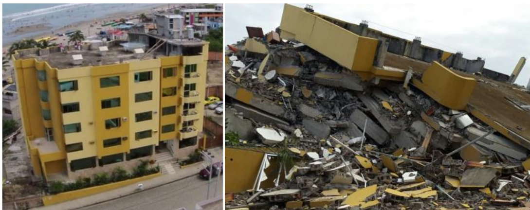
Figura 1. Hotel Royal, antes y después del terremoto (Fuente: Ecuador Noticias, 2016 y El Comercio , 2016a)
